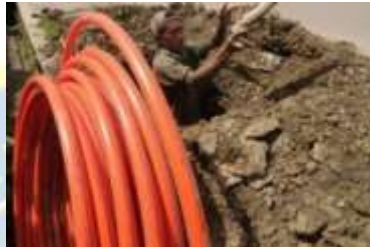
Gambar 4. 2 Pemasangan Fiber Optik di Kabupaten Bekasi
