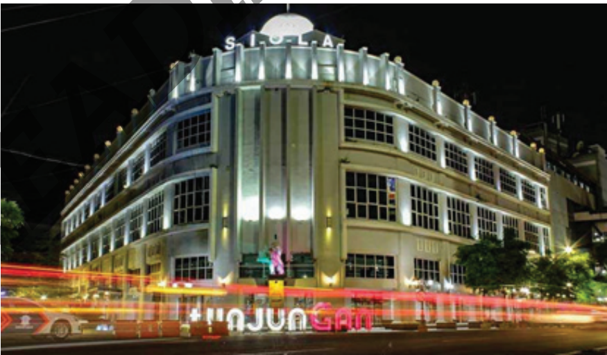
Gambar 10.32 Gedung MPP Surabaya
