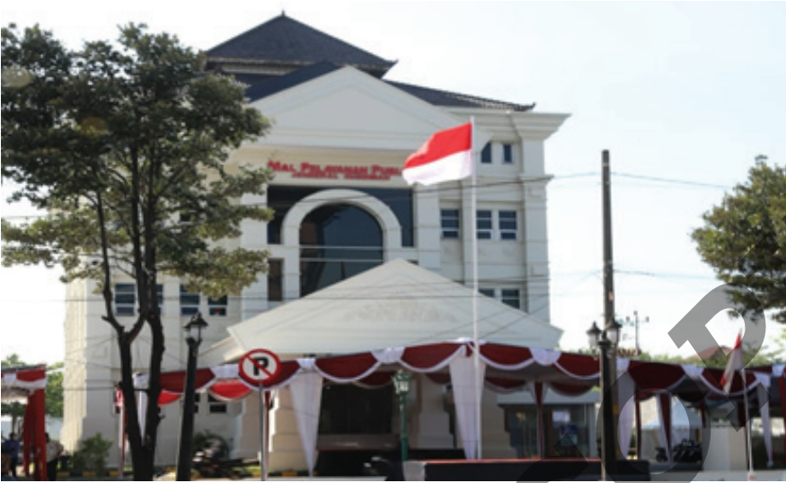
Gambar 10.26 Gedung MPP Surakarta
