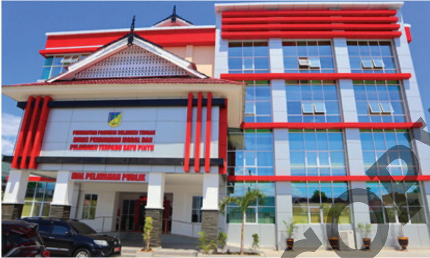
Gambar 10.48 Gedung MPP Sulawesi Tengah
