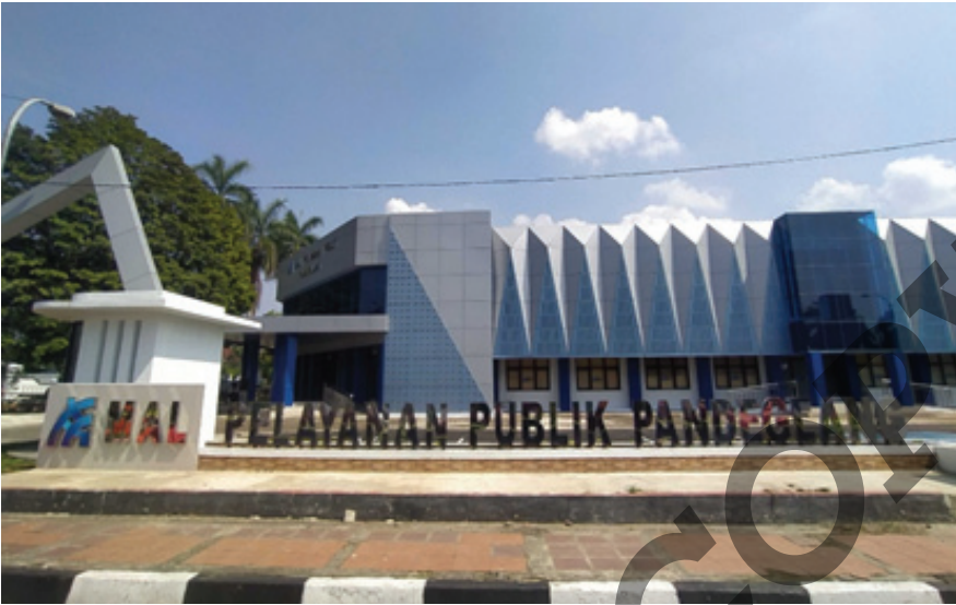
Gambar 10.12 Gedung MPP Pandeglang
