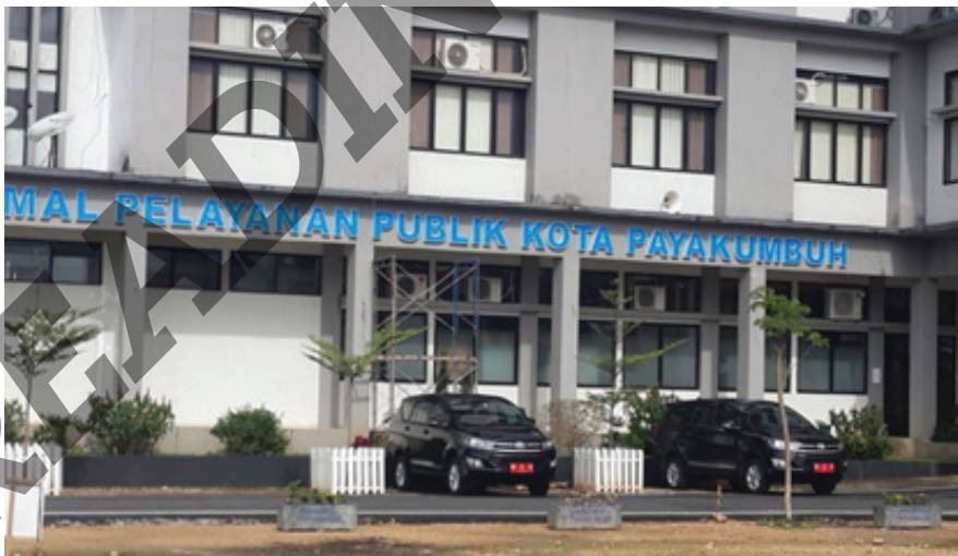
Gambar 10.10 Gedung MPP Kota Payakumbuh
