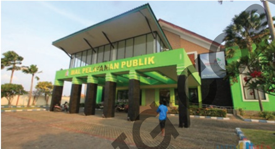
Gambar 10.36 Gedung MPP Probolinggo
