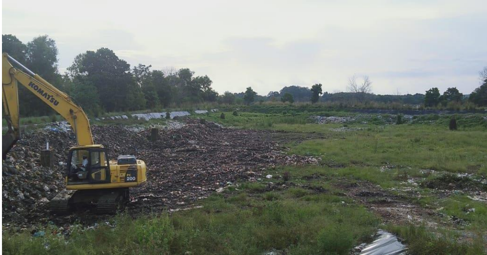
Gambar : TPA Kecamatan Tulang Bawang Tengah
